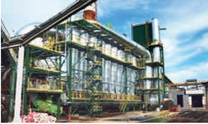
Multizyklone des Spänetrockners
