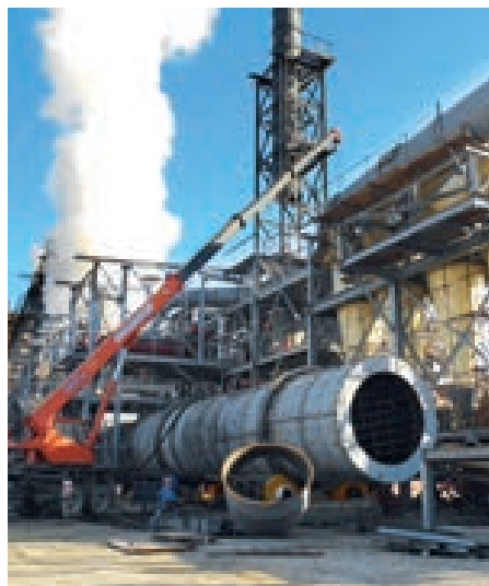
Die Trockentrommel wird vor der schon installierten Brennkammer in Position gebracht
