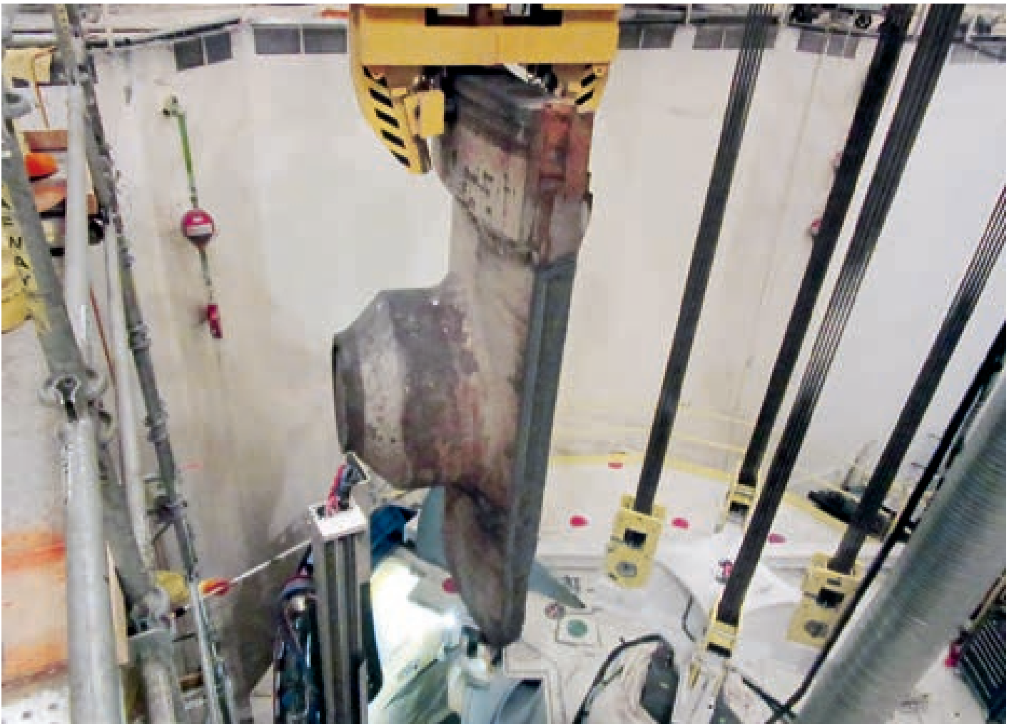
Herausheben des ersten Stützelements
