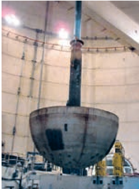
Reaktorboden an der Hubstange
