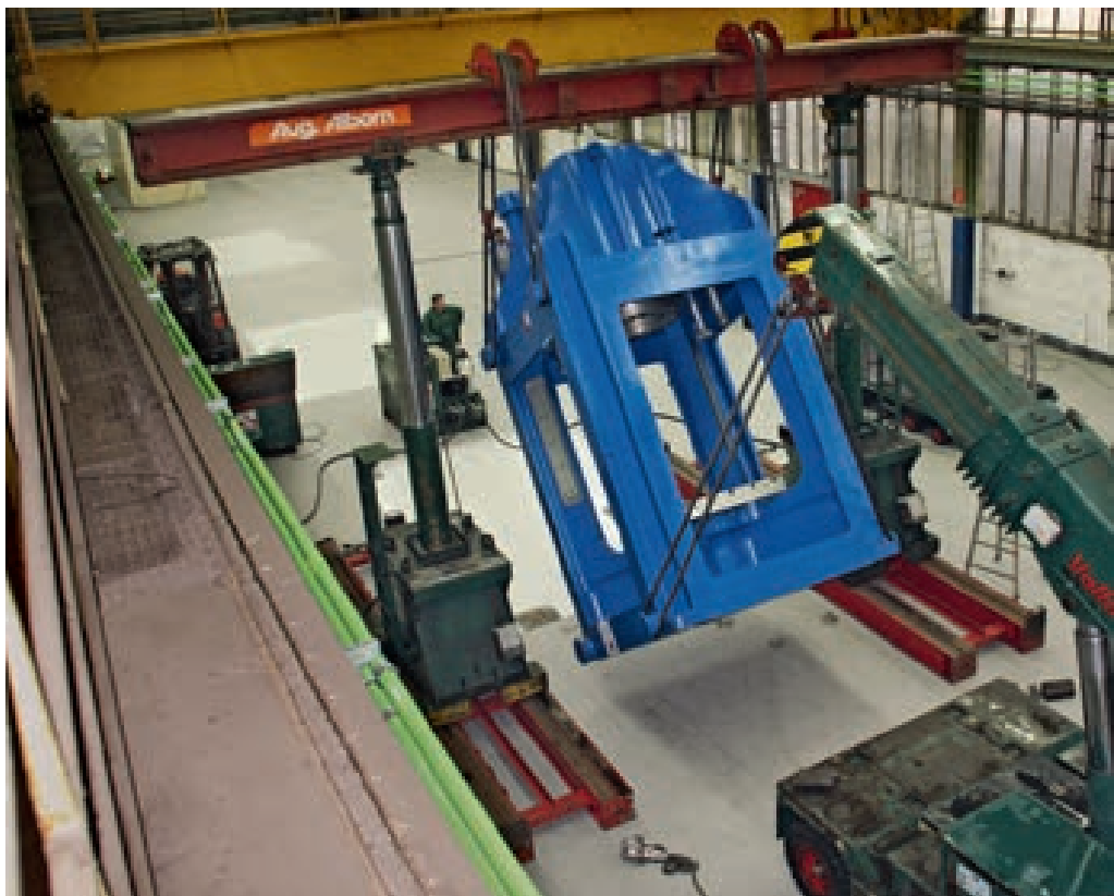
Einbringung des einteiligen Pressenkörpers aus Sphäroguss
