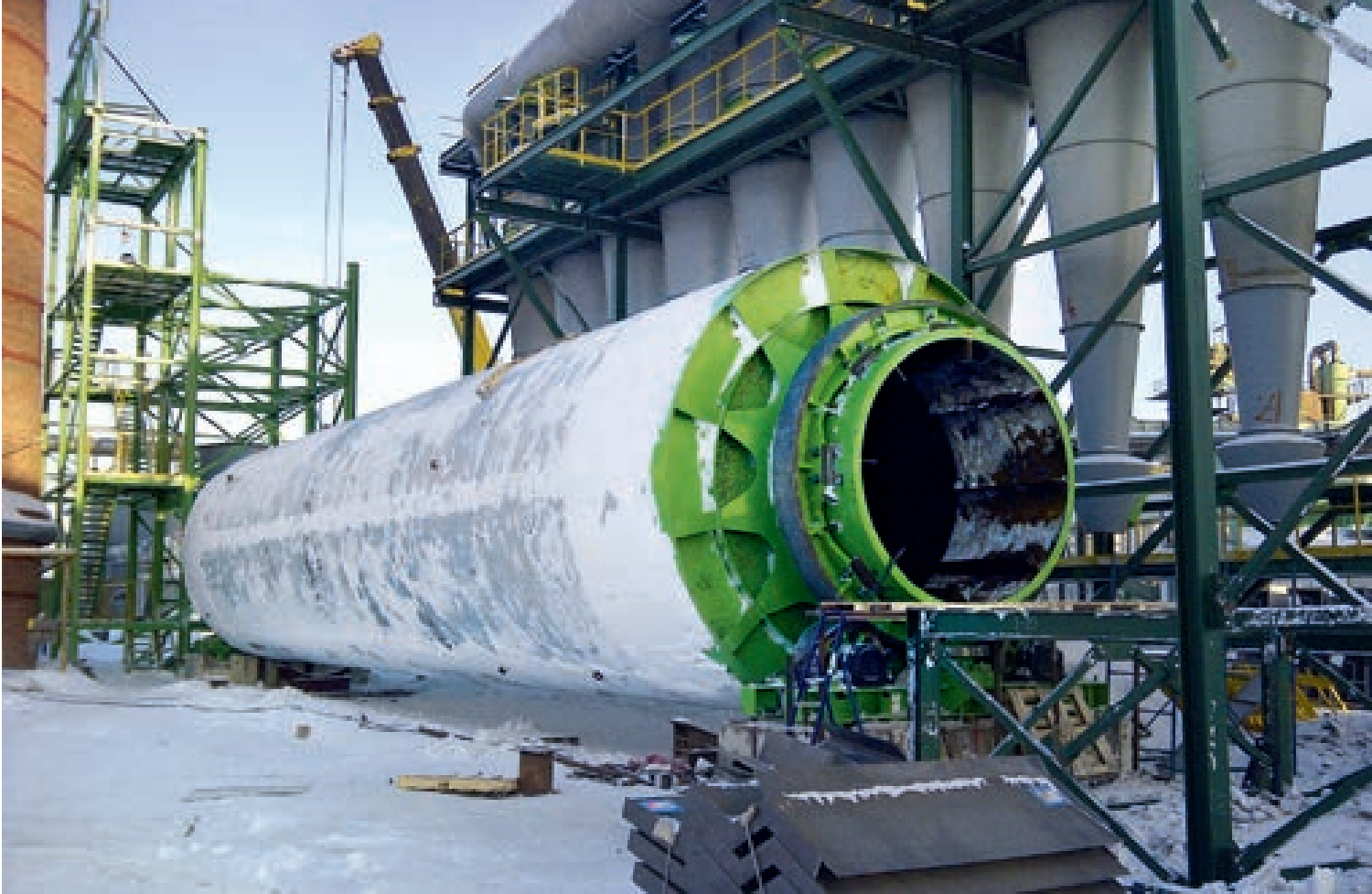
Montagearbeiten am Büttner-Trommelrockner
