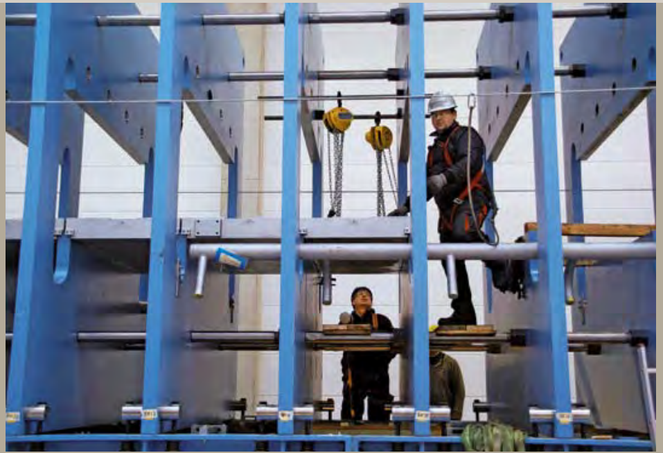
Verlegen der Druckverteiplatten
