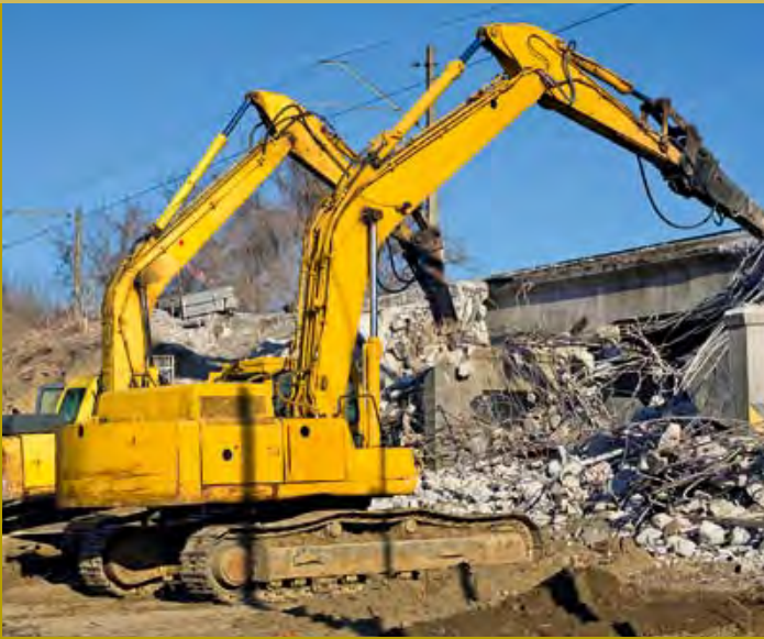
Abriss von Militärgebäuden, z. B. Tankstellen, Wohngebäuden etc.
