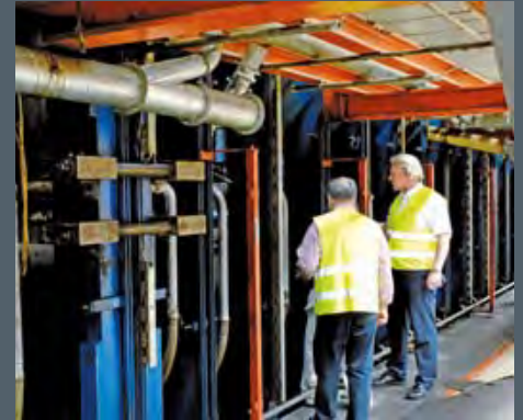
Inspektion der Umbauarbeiten durch Siempelkamp-Mitarbeiter
