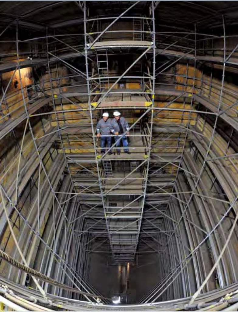
Eingerüstet zur Inspektion: das Kesselhaus (Foto: Andreas Seidel, Chemnitz)
