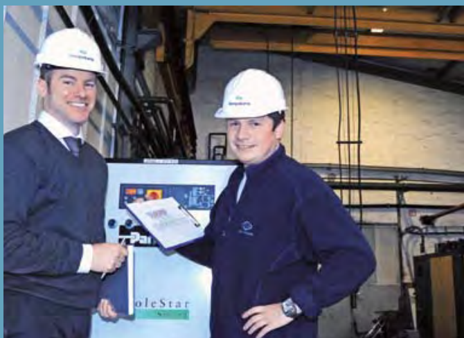
(v.l.n.r.) Die Energiemanager Benedikt Szukala und Sergej Rubzow während der Leistungsüberprüfung der Kompressoren für Rückschlüsse auf Leckagen
