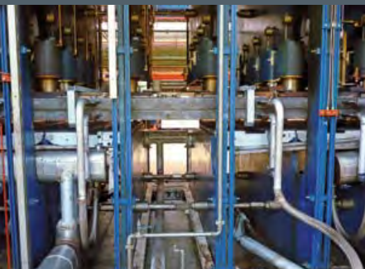
Angehobene Heizplatten mit eingelegeten Druckverteilterplatten
