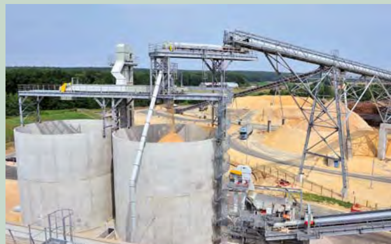
Hackschnittsilsilos mit Austrag und Schwingsieb
